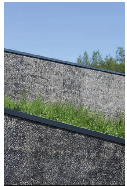
Vue du mur de la façade d'entrée en béton désactivé.
