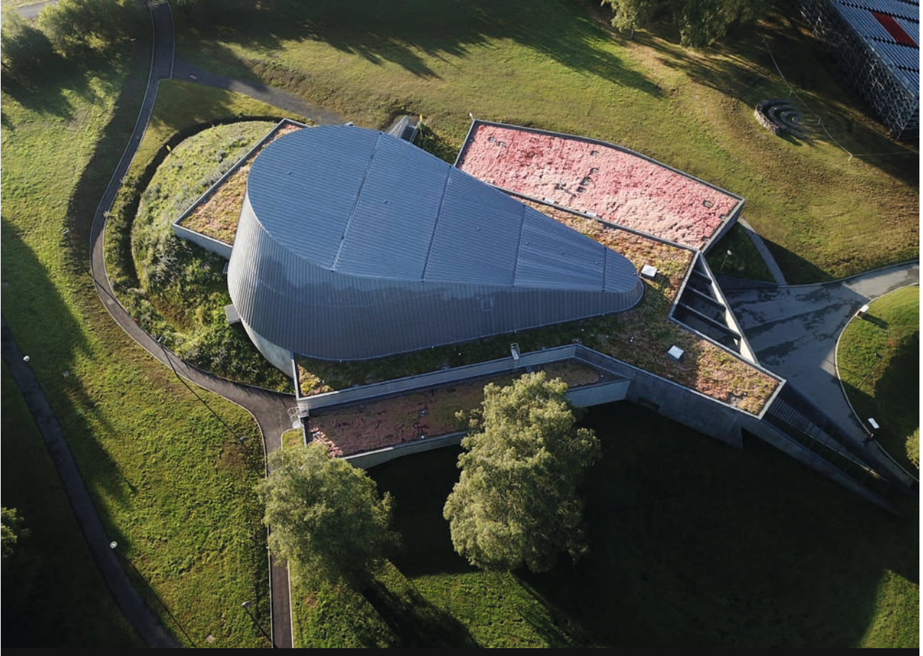
Vue aérienne sur le dôme métallique et les toitures végétalisées.
