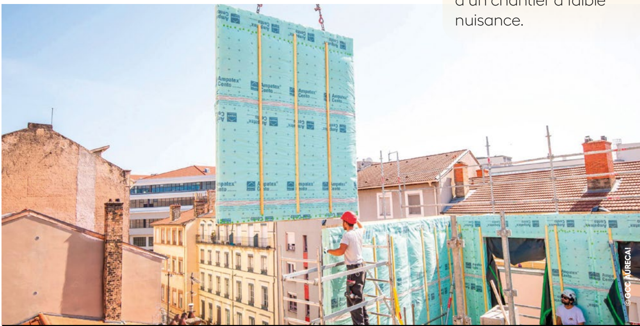
La préconstruction des panneaux hors site permet un assemblage rapide réduisant au maximum les nuisances du chantier.
