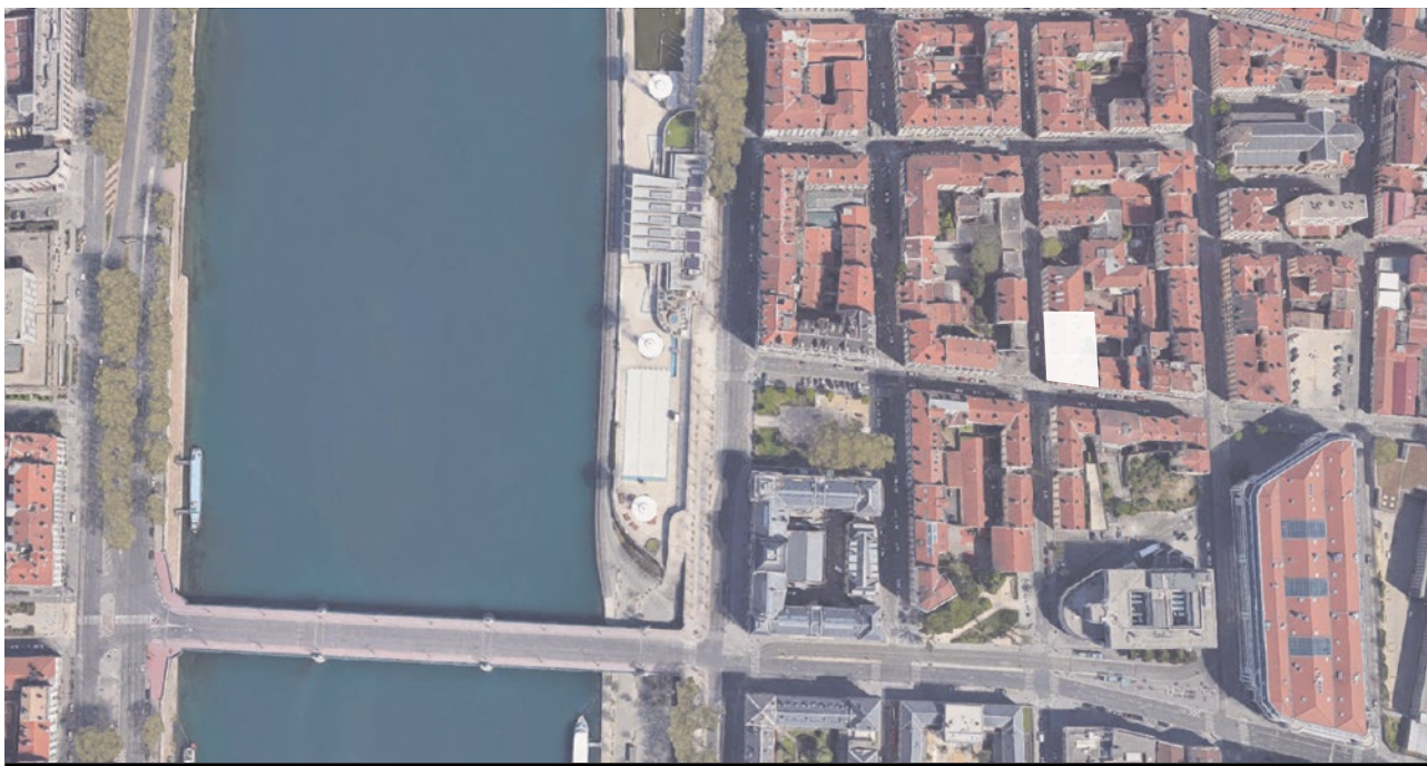
La résidence étudiante Renée Vivien en plein cœur du périmètre d'intérêt patrimonial dans le 7 e arrondissement.
