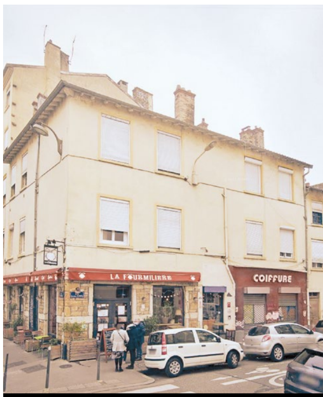
Visuel du bâtiment C avant le début des travaux.
